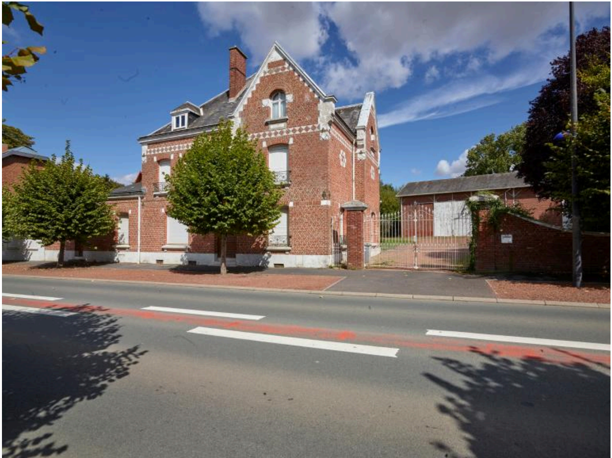
Ferme, n° 66 rue du faubourg de Péronne. Vue générale depuis la rue. Ferme sur cour avec maison d'habitation à front de rue.
