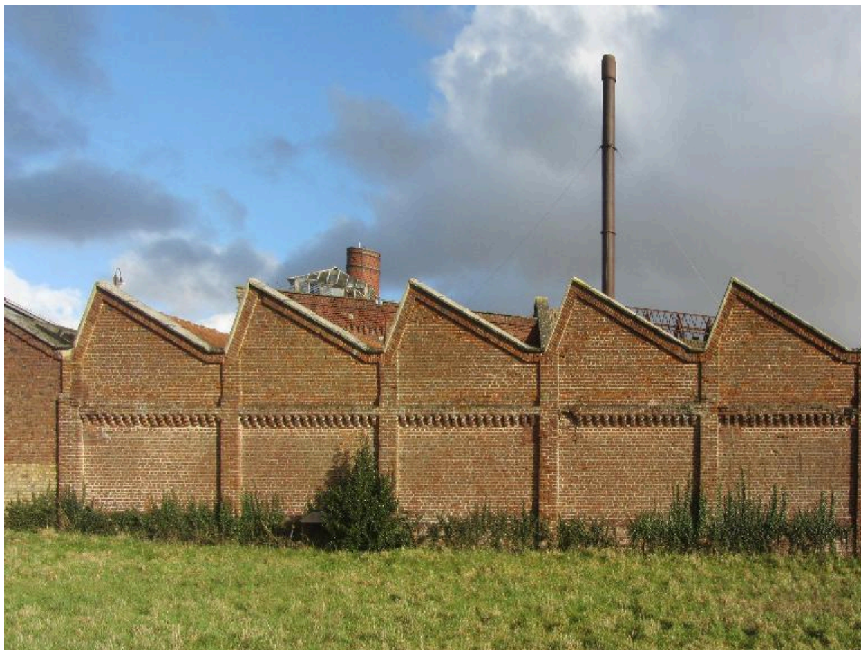
Pignons ouest en sheds des ateliers d'apprêts.
