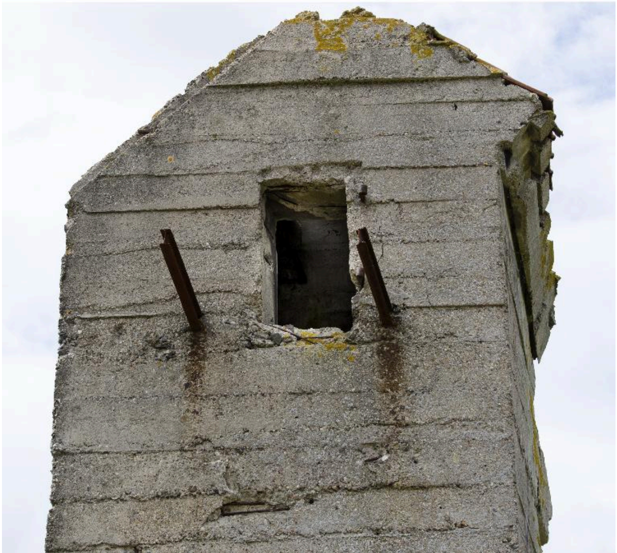
Vue de l'ouverture haute du "pignon" sud-est de l'observatoire
