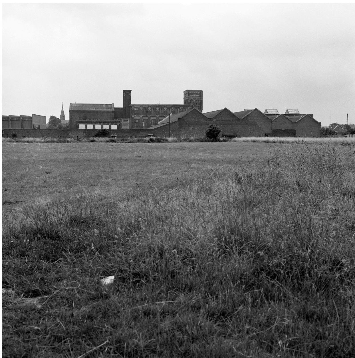
Vue générale prise depuis le nord.
