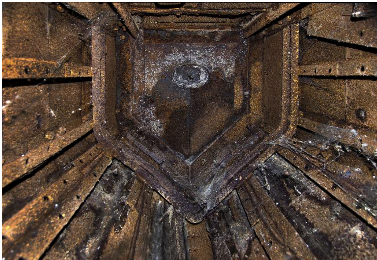
Seconde salle sud : Vue zénithale de l'observatoire cuirassé
