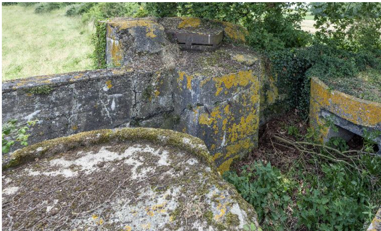
Vue d'ensemble vers le sud
