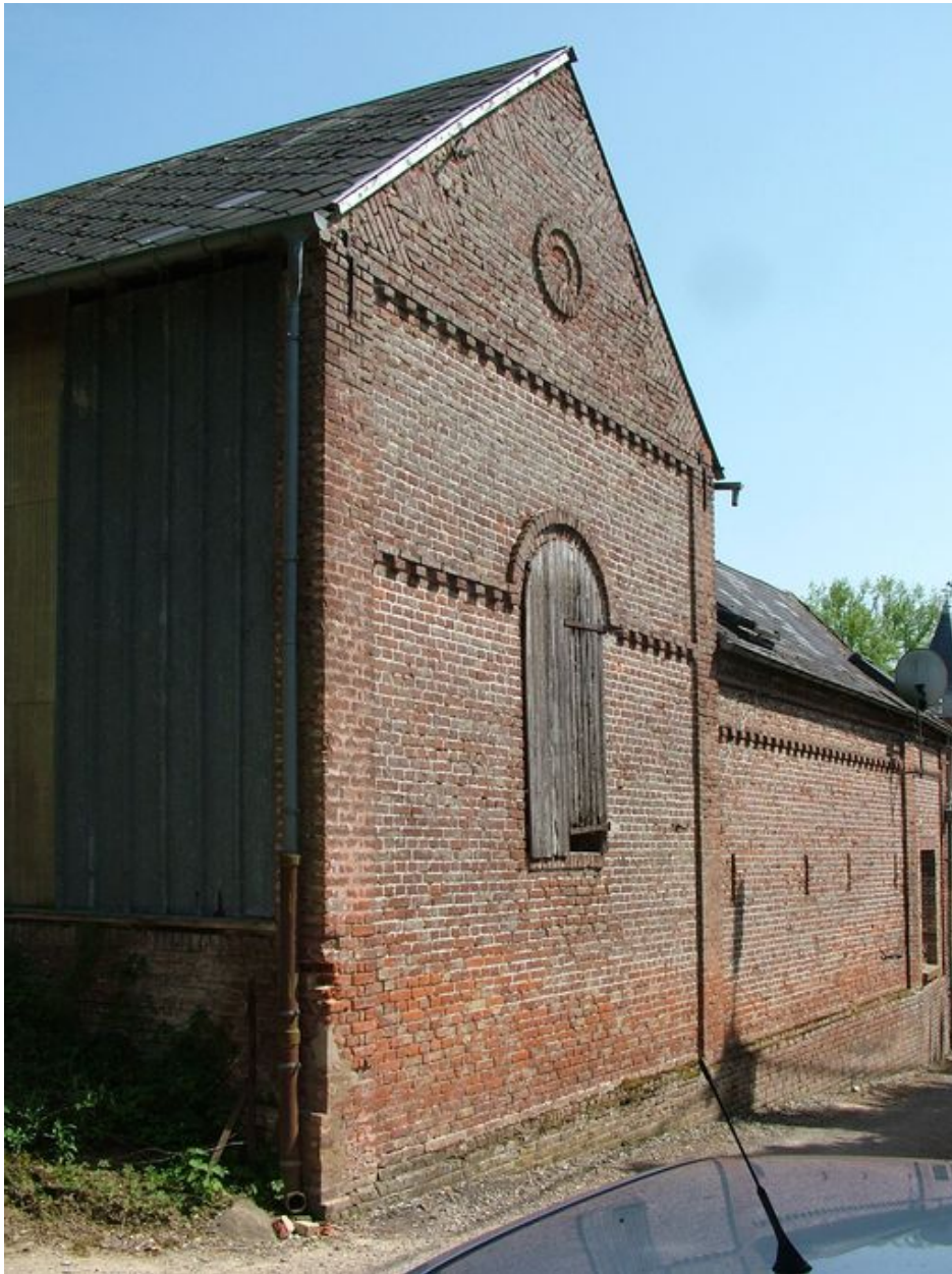
Mur-pignon de la grange.
