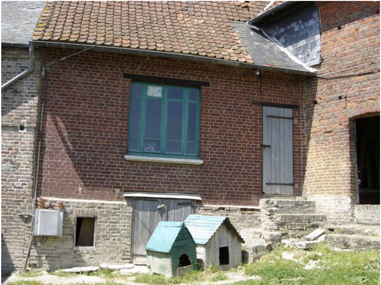
Vue extérieure de la cave située sous le second logement.
