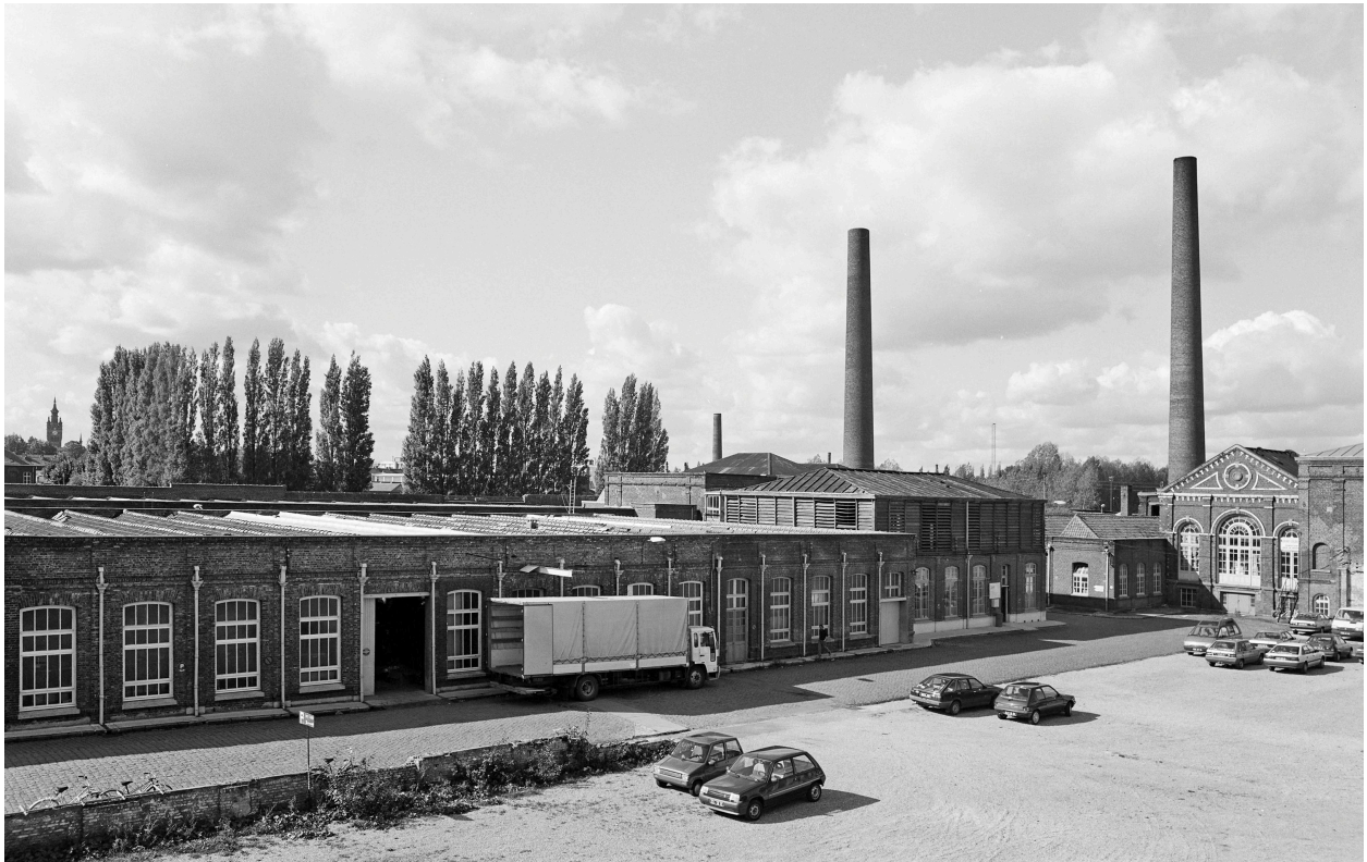
Vue générale prise vers le nord-ouest.
