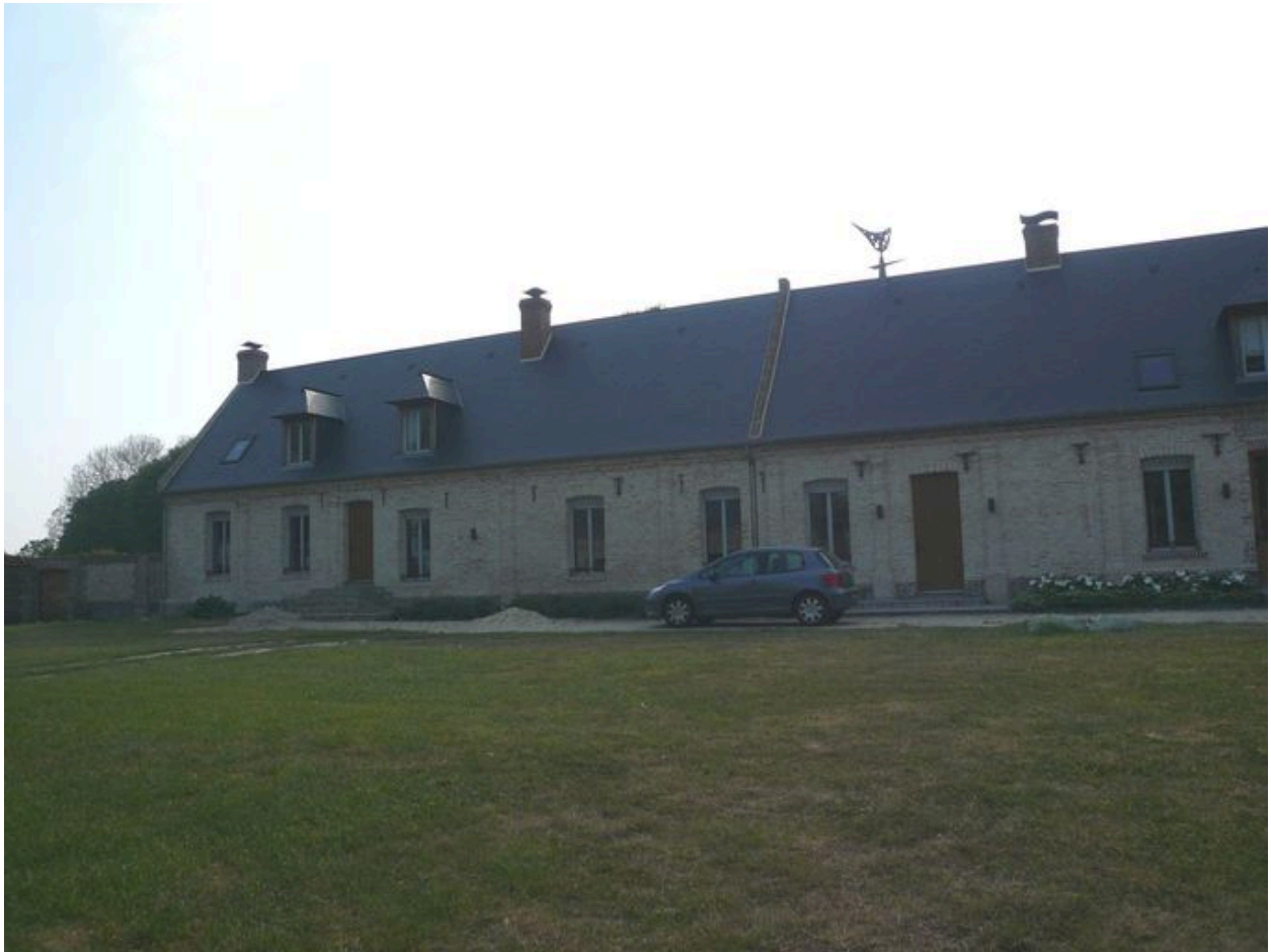
Vue détaillée de la façade du logis, au sud.
