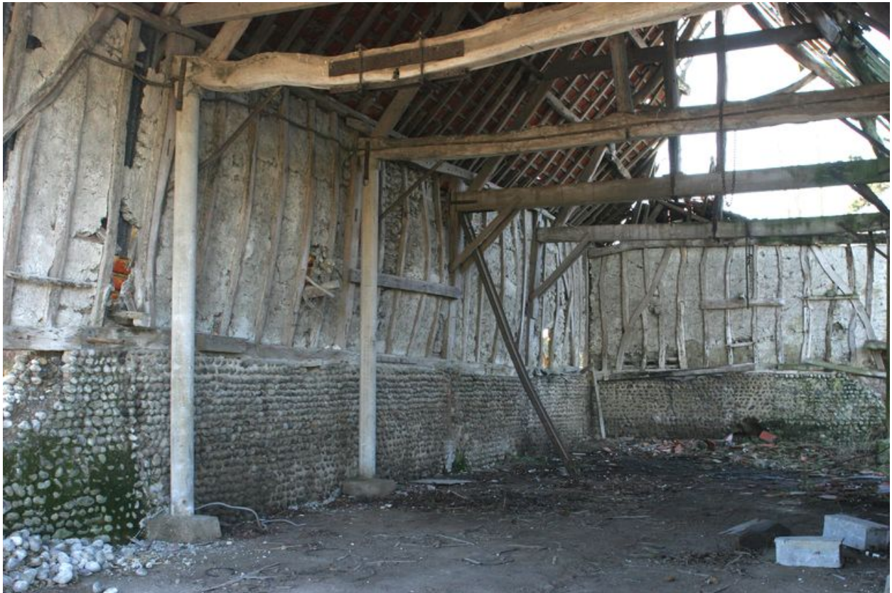
Vue intérieure de la grange.
