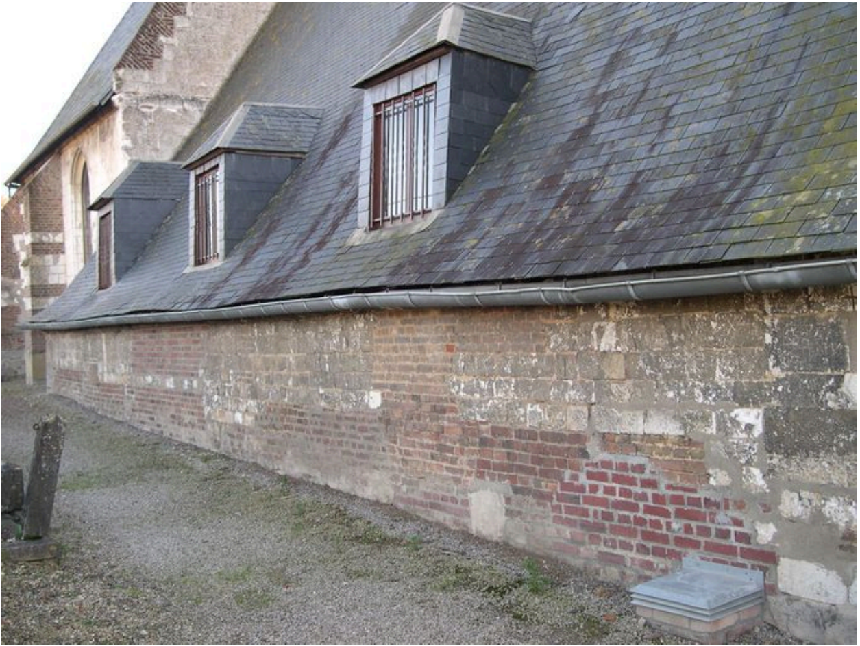
Vue du bas-côté nord.
