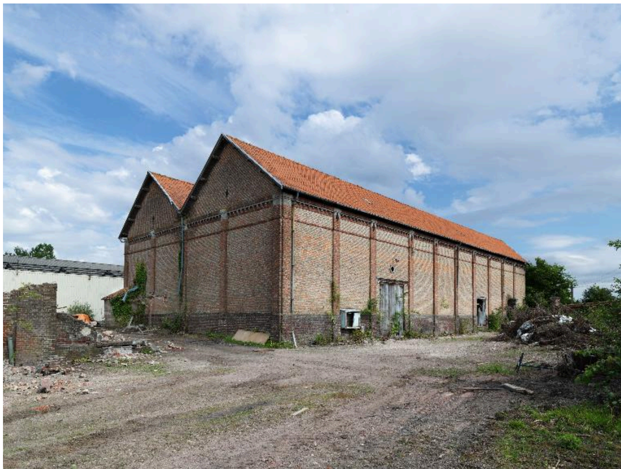
Vue d'ensemble des entrepôts avant destruction, juillet 2012.
