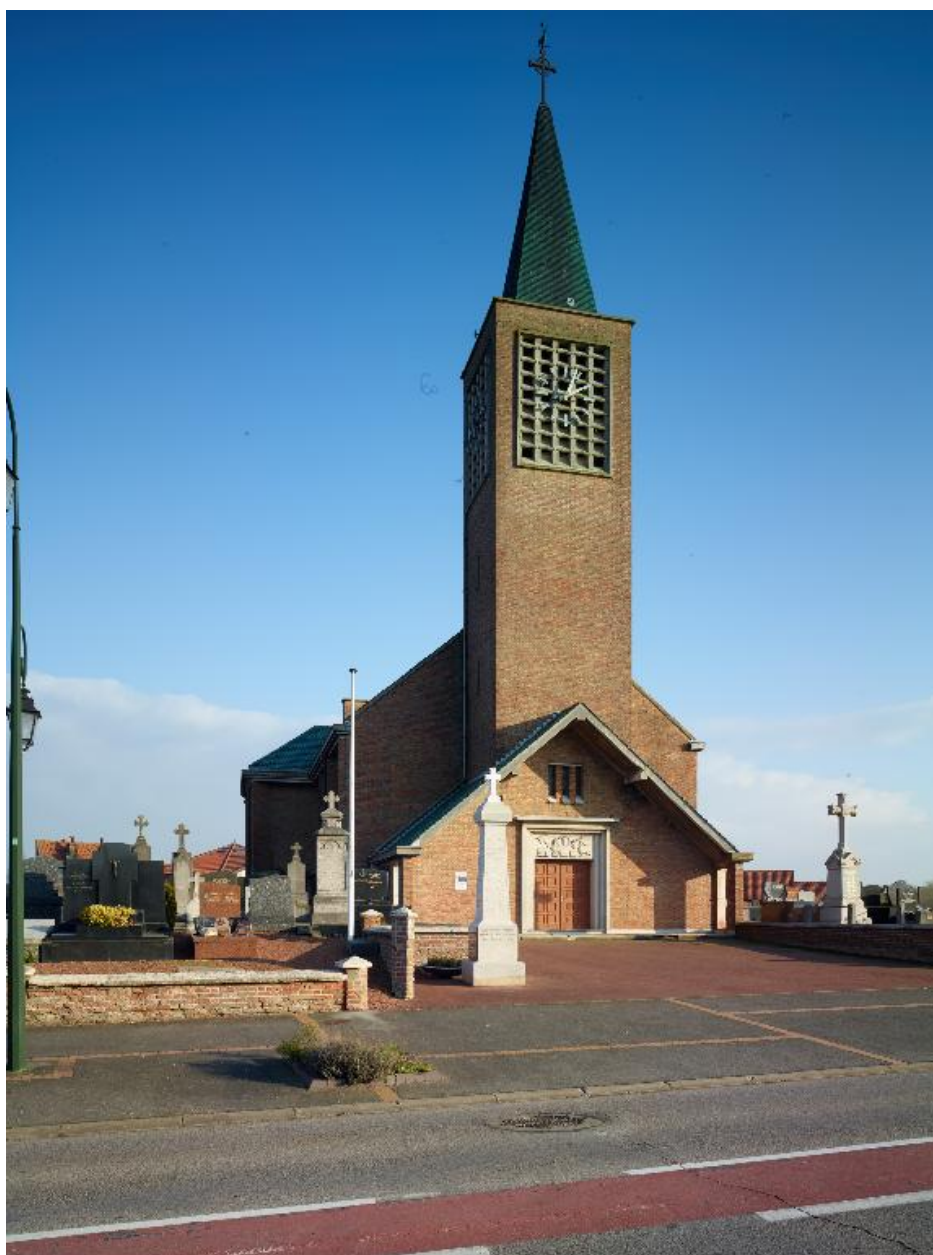
élévation antérieure de trois quart gauche
