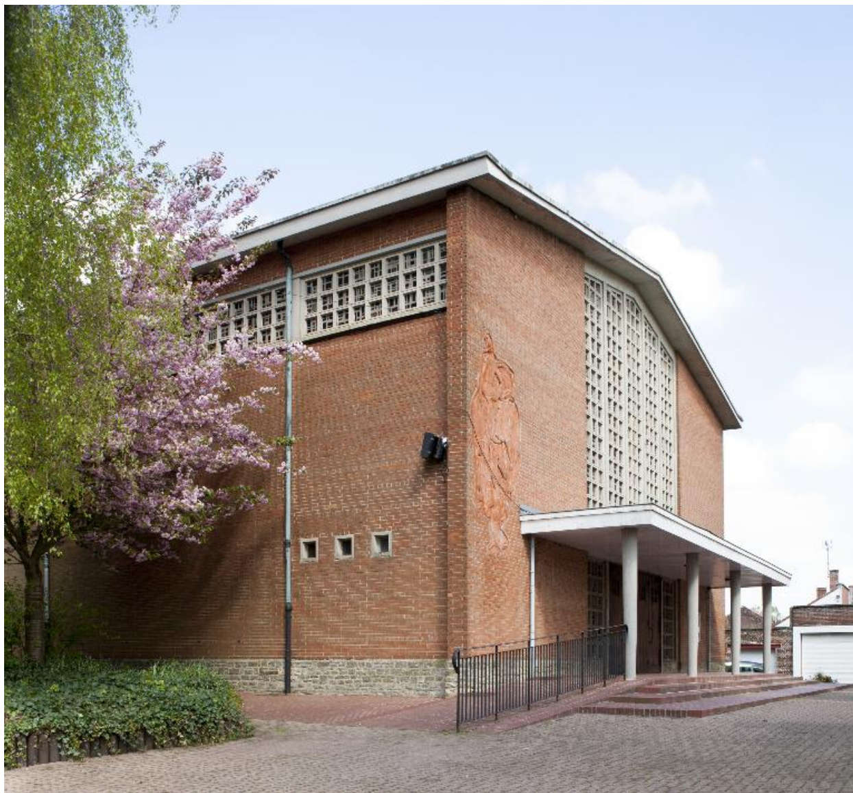
Vue trois-quart entrée église et flanc gauche.
