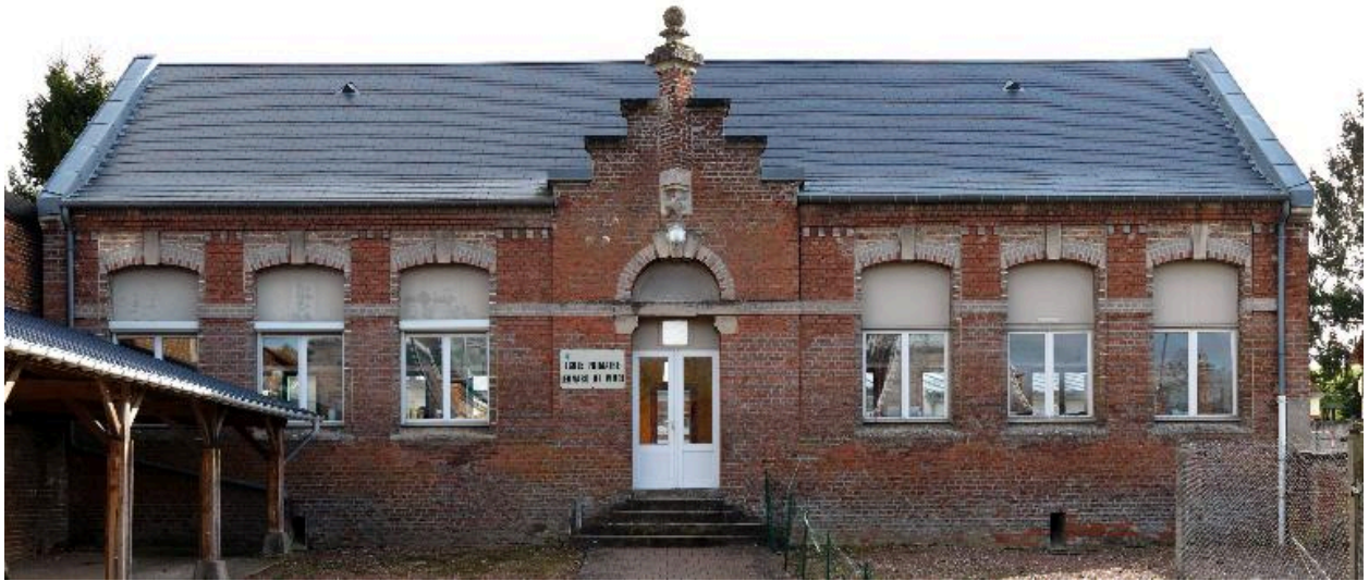
Berteaucourt-les-Dames, ancienne école de filles, Louis Henry Antoine architecte, 1876 et 1894.
