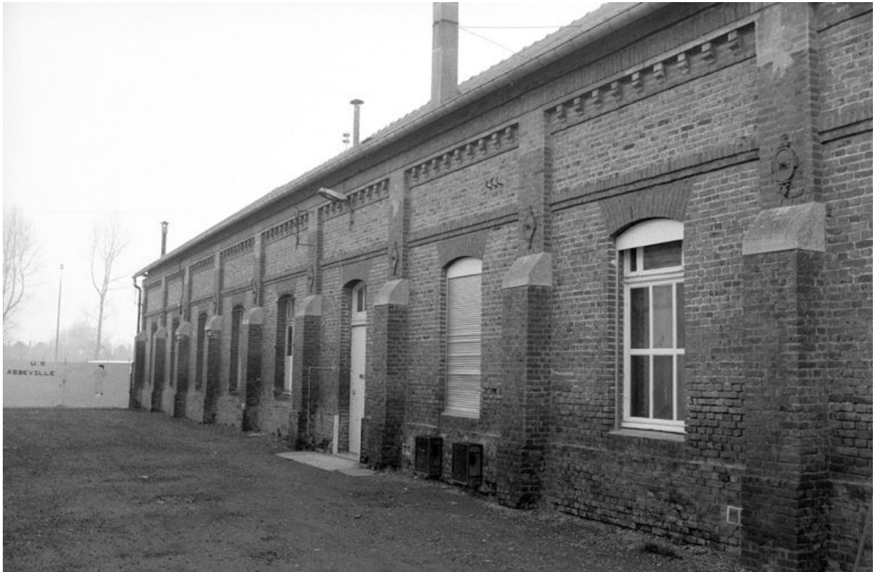
Vue du bâtiment sud.
