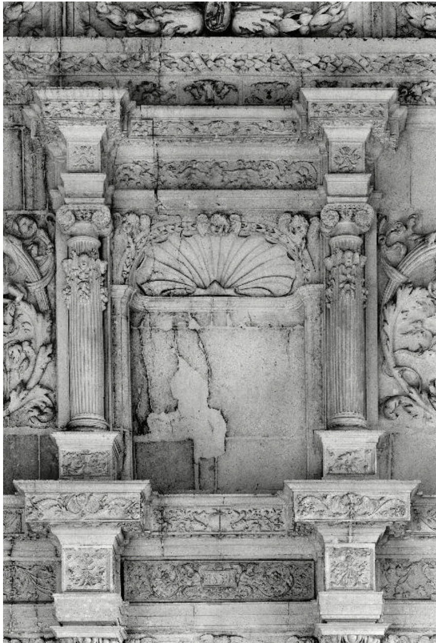
Vue de la niche du niveau supérieur.
