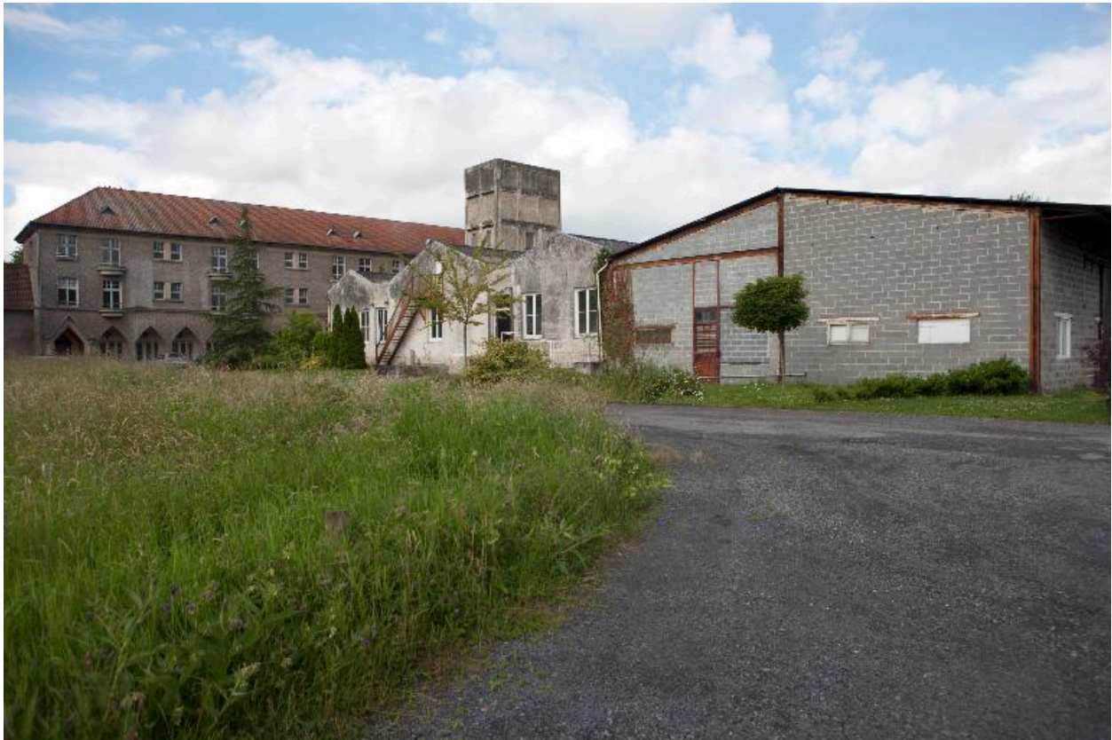
Vue générale de l'élévation postérieure de l'établissement thermal.
