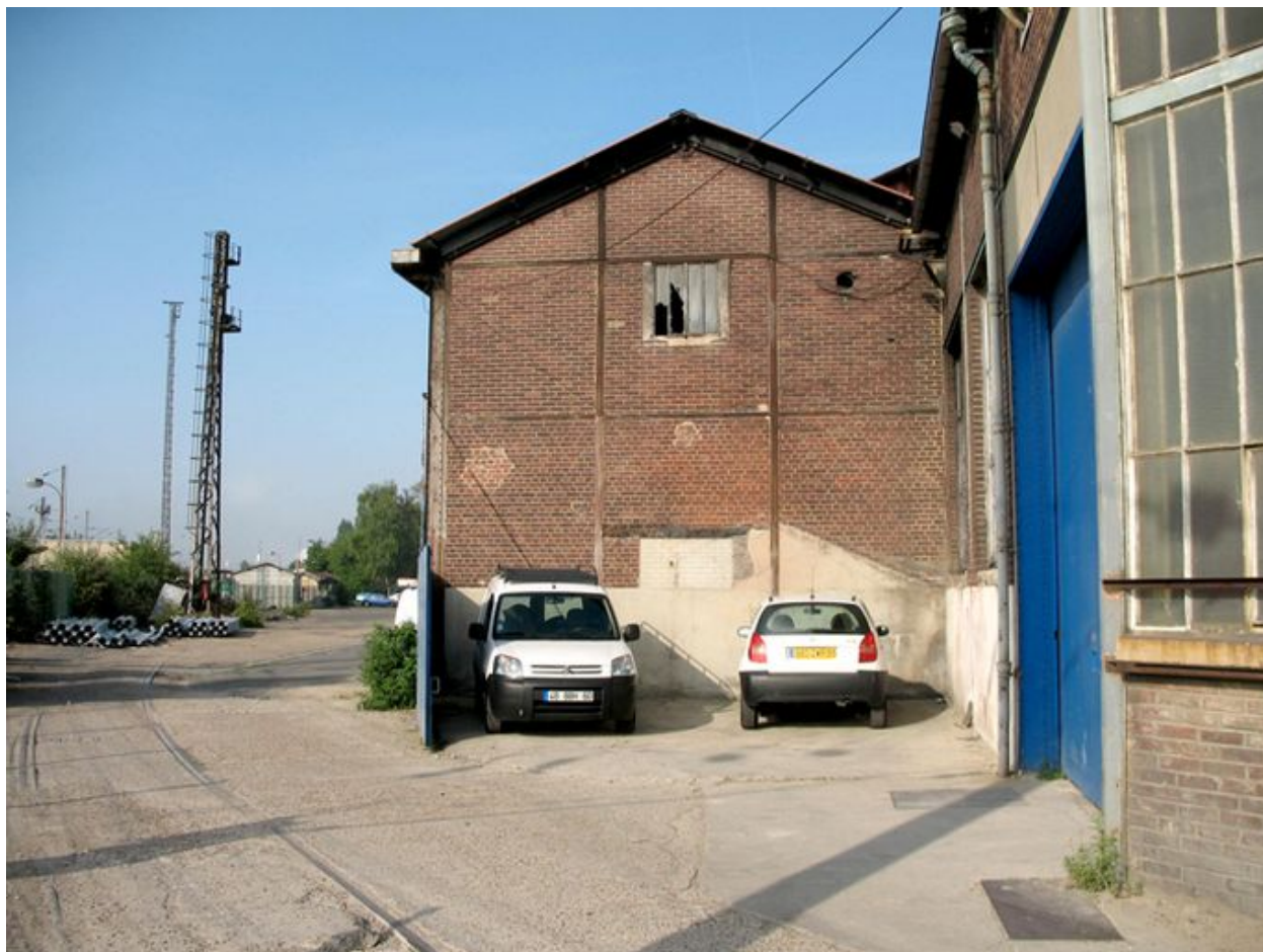
Mur pignon de l'atelier de mécanique et d'ajustage.
