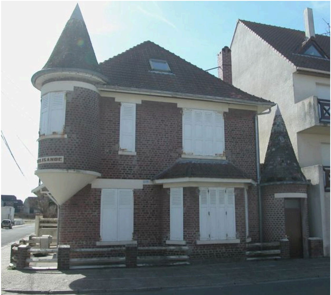
Elévation antérieure, rue de l'Amiral-Courbet.
