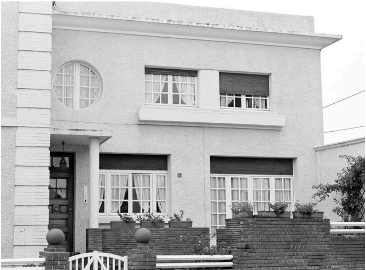
Logement patronal : détail de la partie édifiée en 1936.
