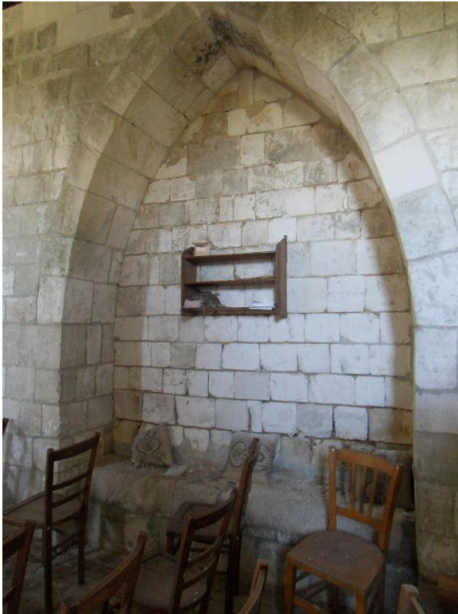
Vue intérieure, deuxième arcature (mur sud).
