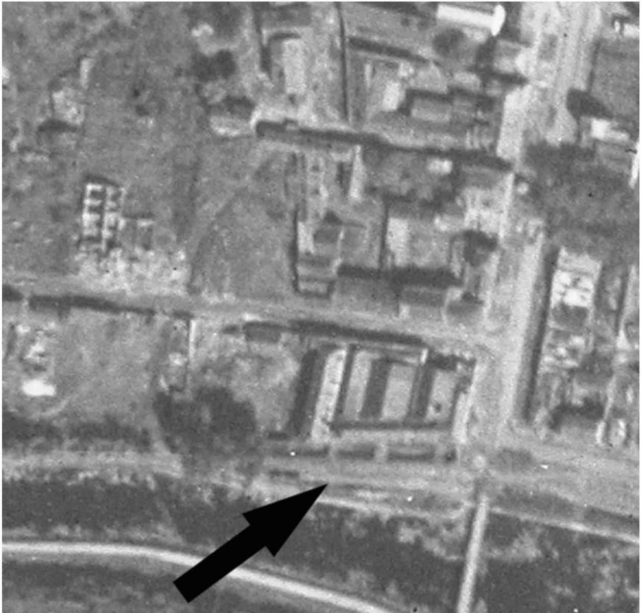
Vue aérienne de l'ancien tissage Boca en novembre 1918 (AD Aisne).
