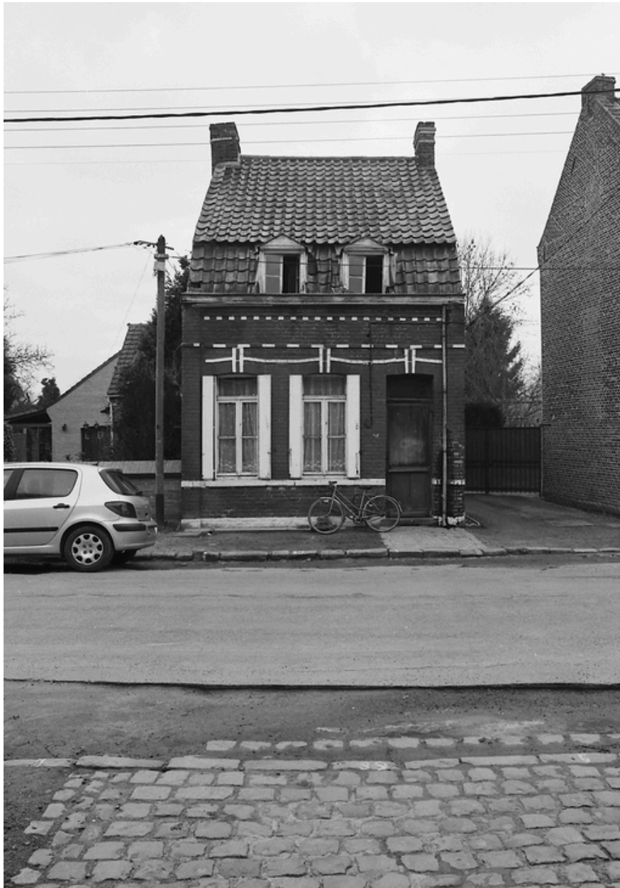
Maison, 46, rue de l'Eglise.
