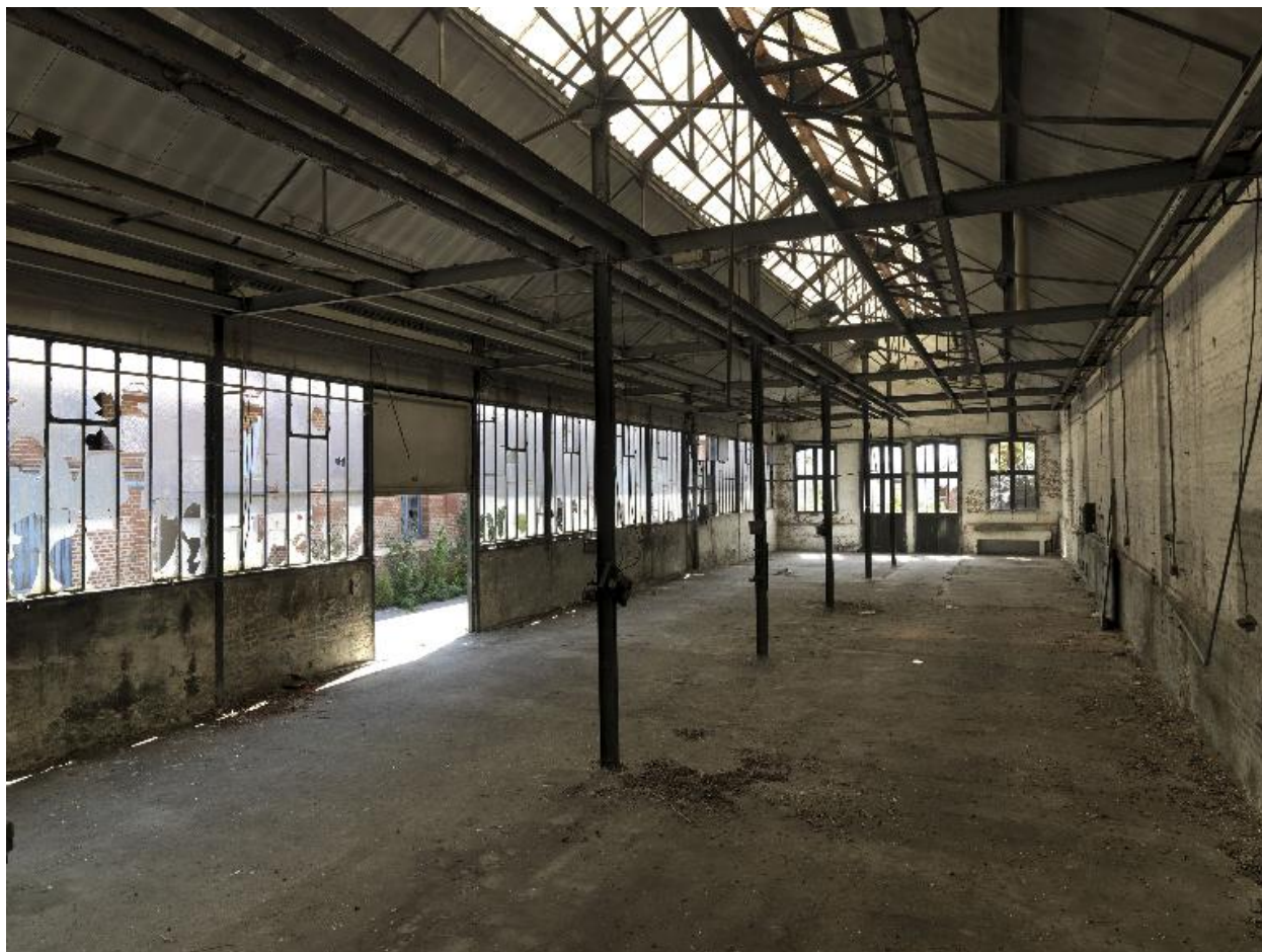
Vue intérieure des anciens ateliers de fabrication.
