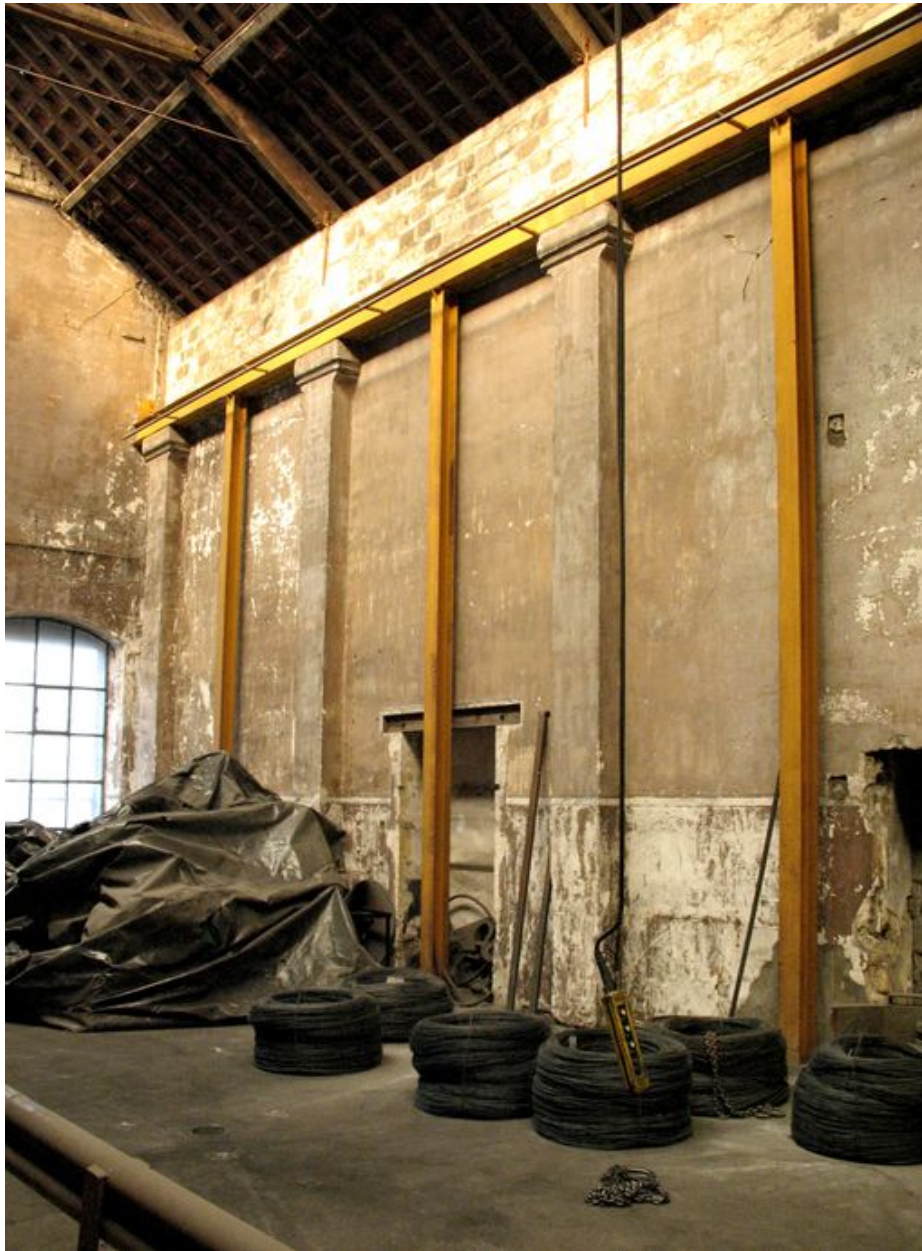
Détail des pilastres à l'intérieur de la halle.
