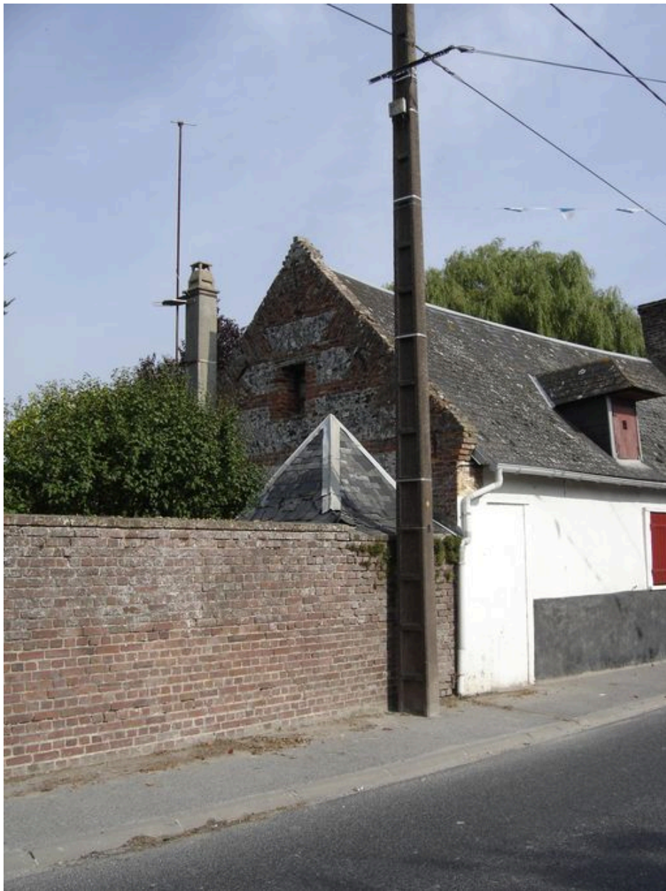
Détail d'un des deux pignons.
