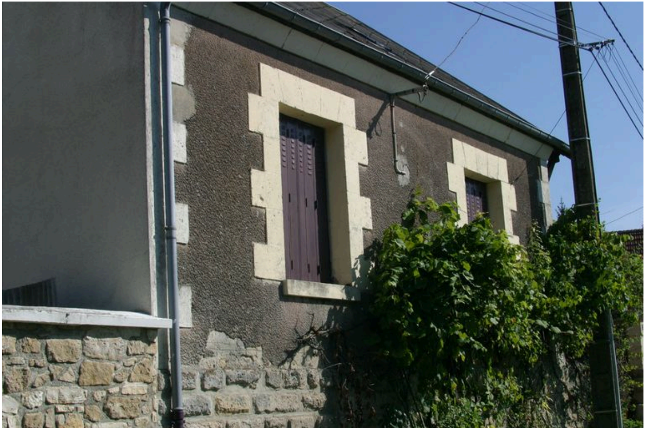
Vue générale de la façade principale.
