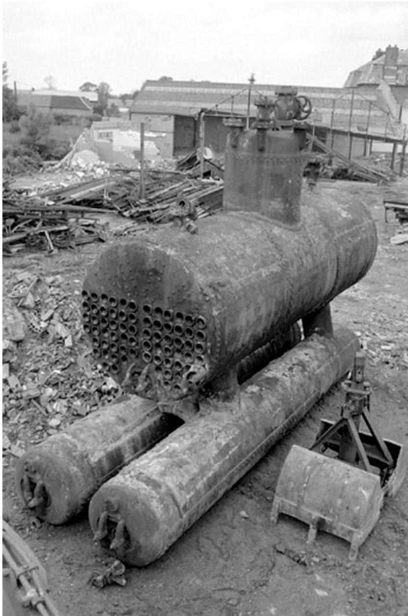
Chaudière avant démolition.
