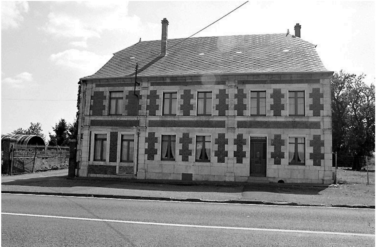
Vue générale du logis sur rue.
