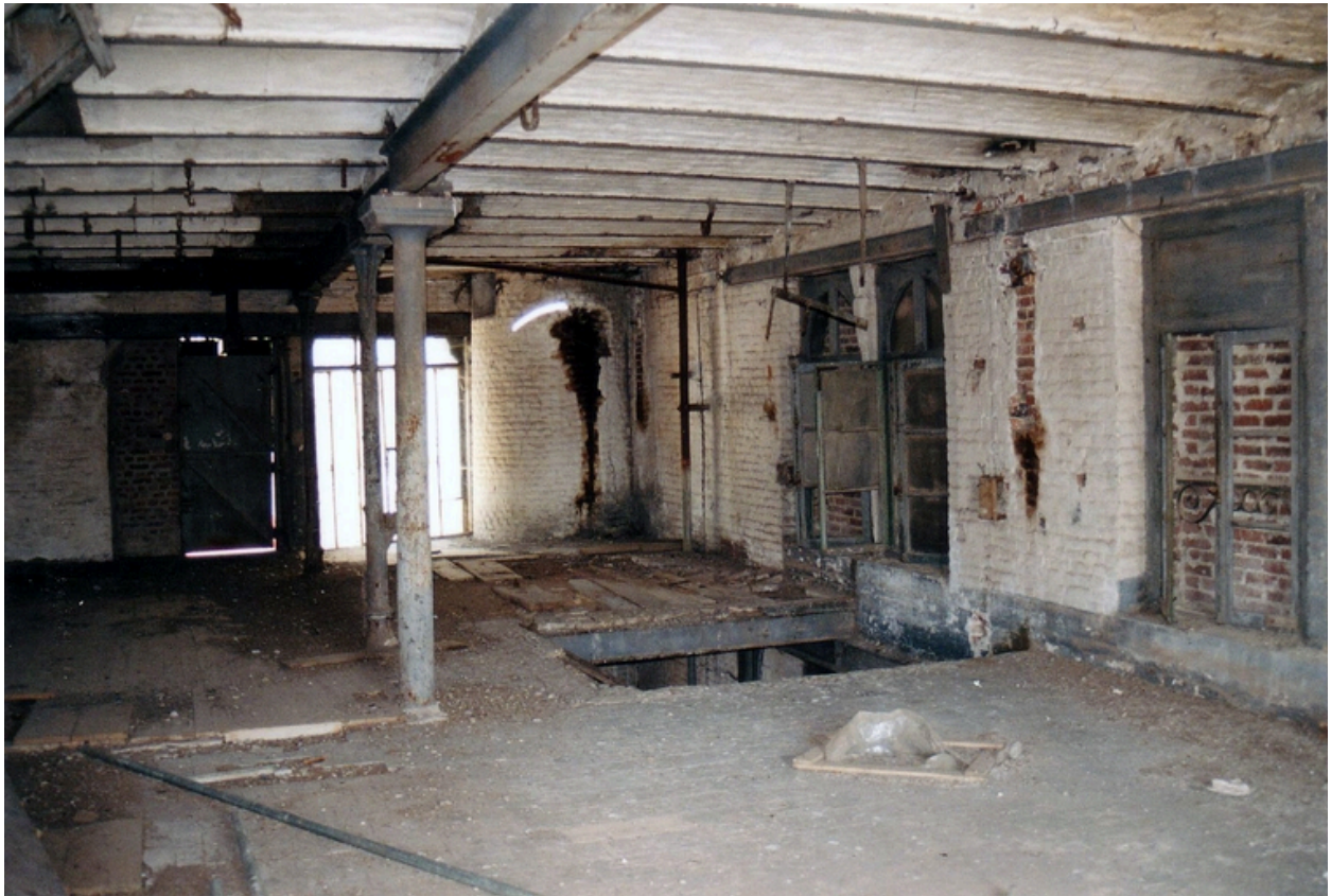
Vue intérieure des ateliers, 1996 (BM Saint-Quentin).
