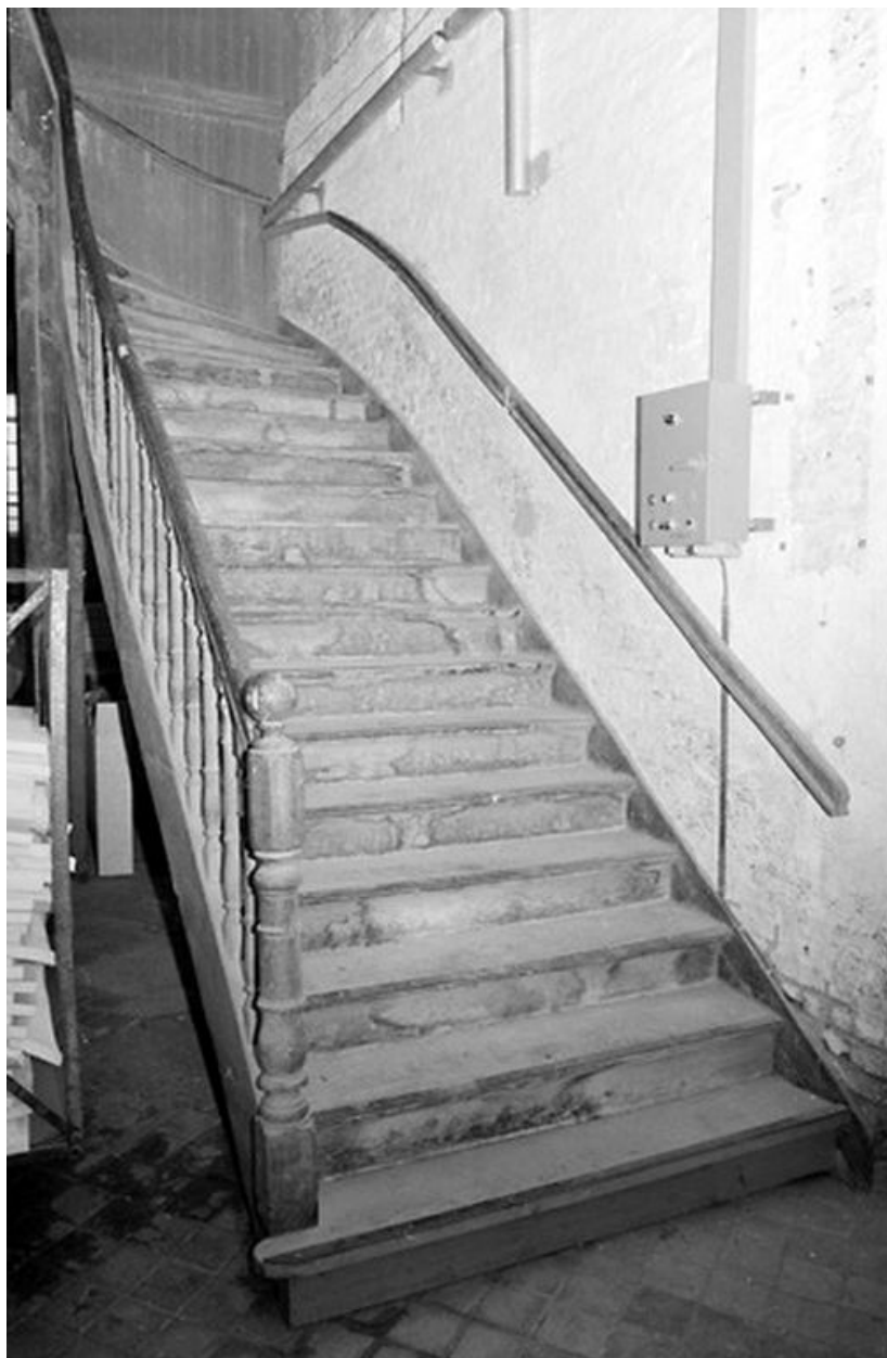
Vue intérieure : escalier.
