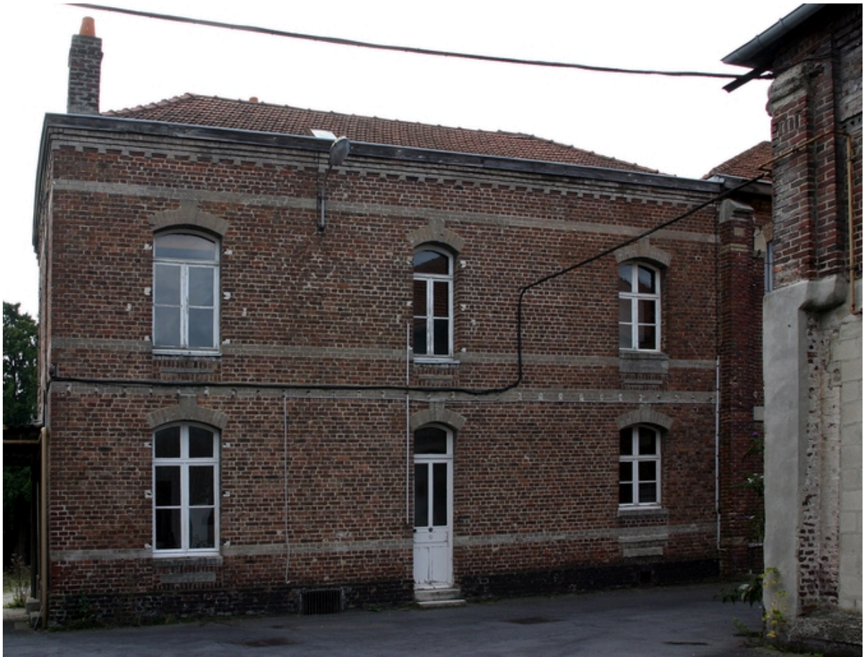
Façade antérieure du logement de contremaître.
