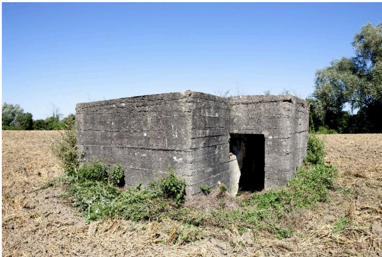
vue de trois-quarts, vers le nord
