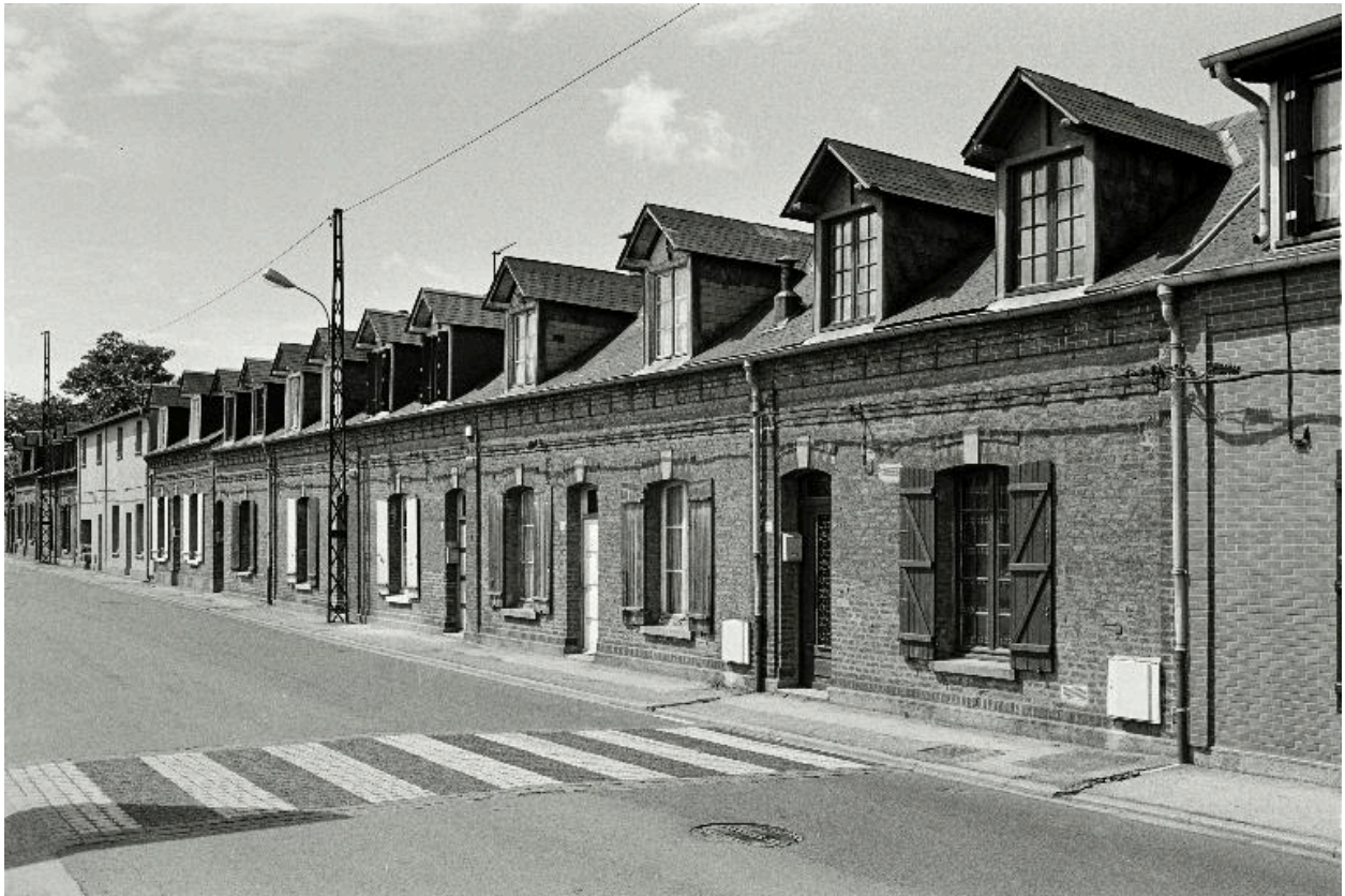
Vue générale de la cité ouvrière, 24 à 48 rue Victor Hugo, en 1990.
