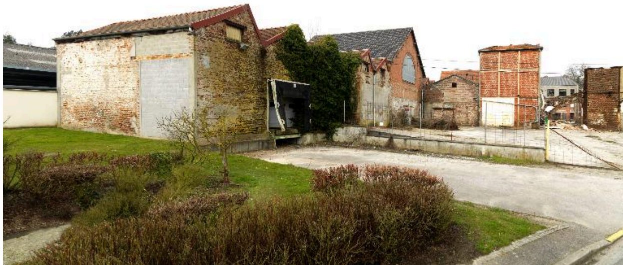
Atelier de fabrication, flanc nord, depuis la rue Karl-Marx.
