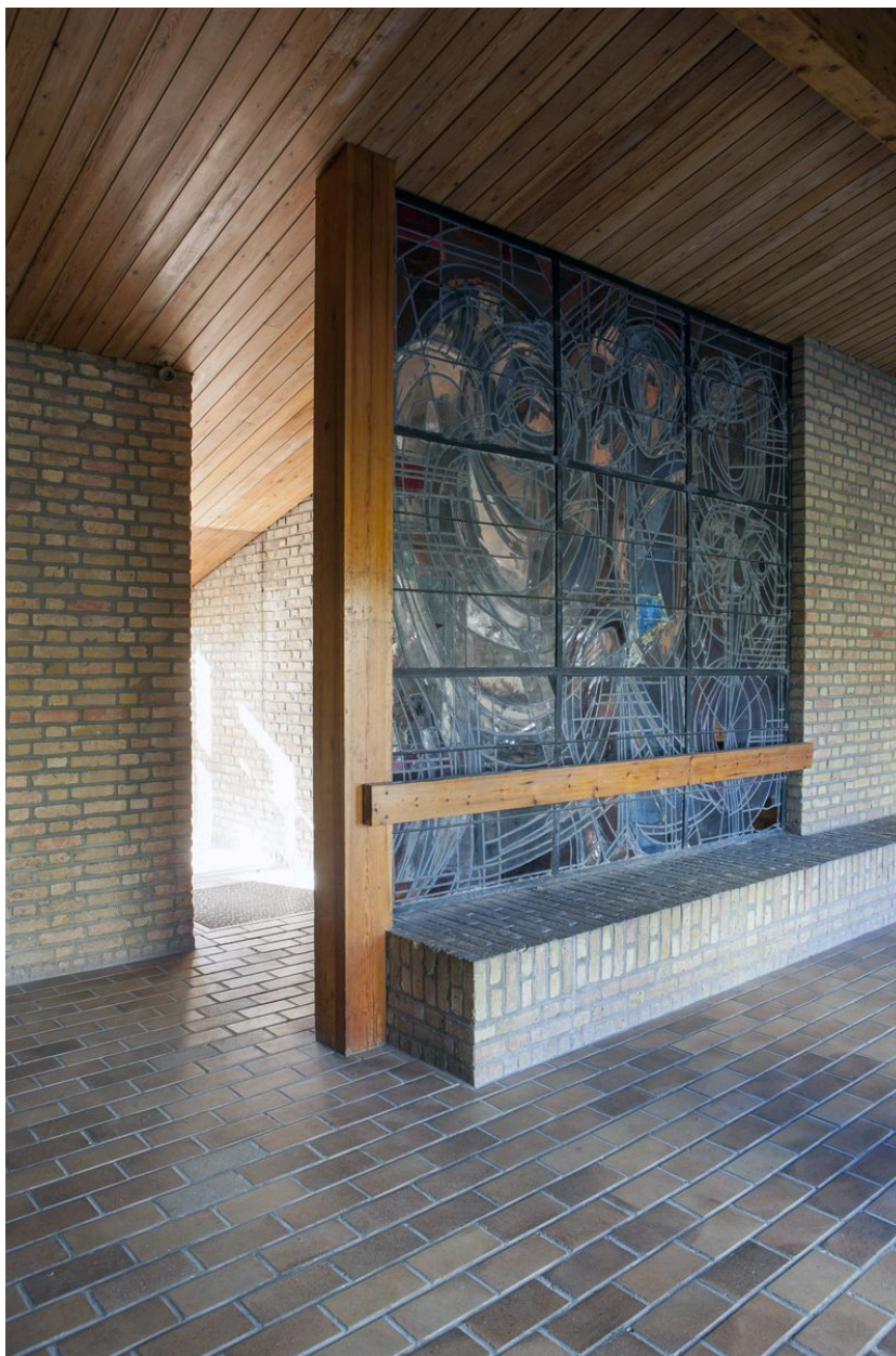
Vue latérale gauche de la verrière du narthex.
