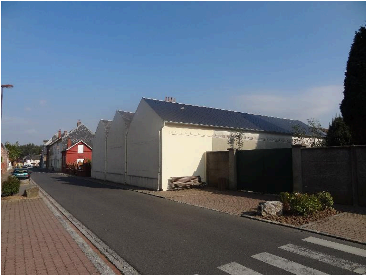
Vue des ateliers depuis la rue Tournière.
