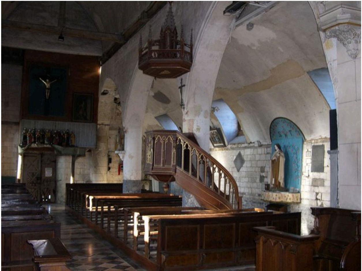
Vue intérieure de la nef et du bas-côté nord.
