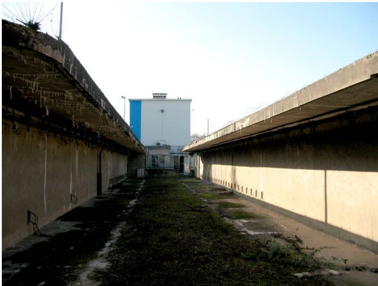
Garage à vélo construit dans les années 1920 pour la fonderie Grange.
