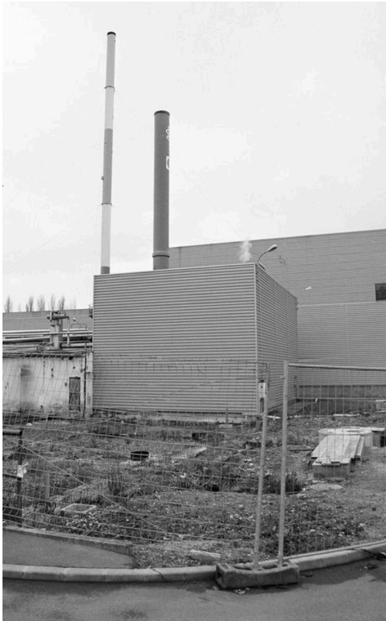
Chaufferie au gaz avec sa cheminée construite en 1996.
