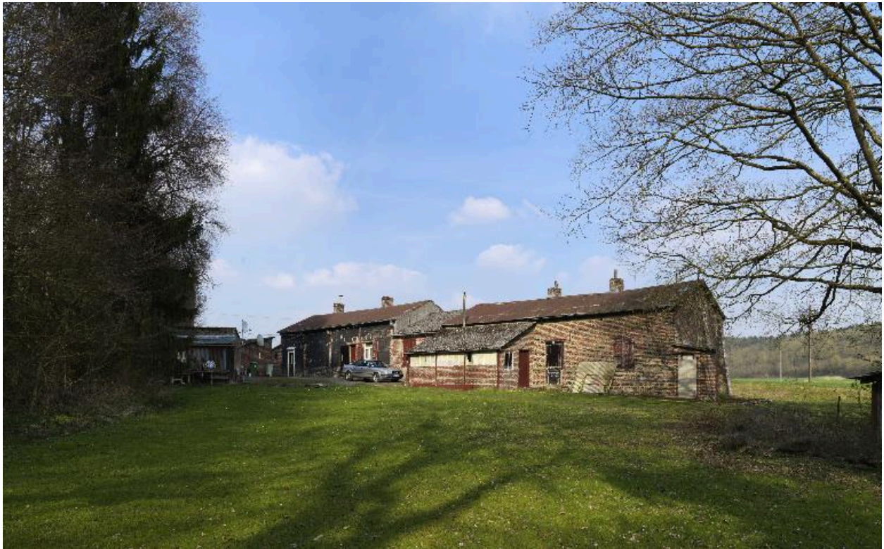
Les logements ouvriers dependants de l'usine.
