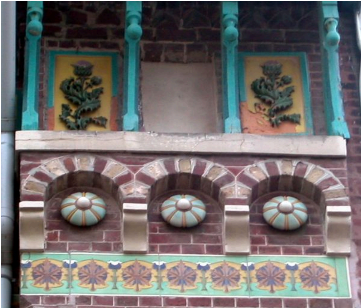
Détail du décor porté en façade.
