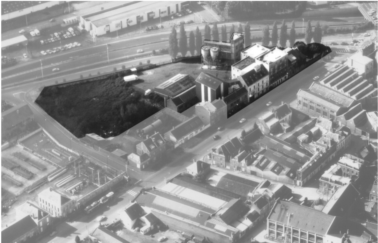
Vue aérienne de la minoterie en 1989.
