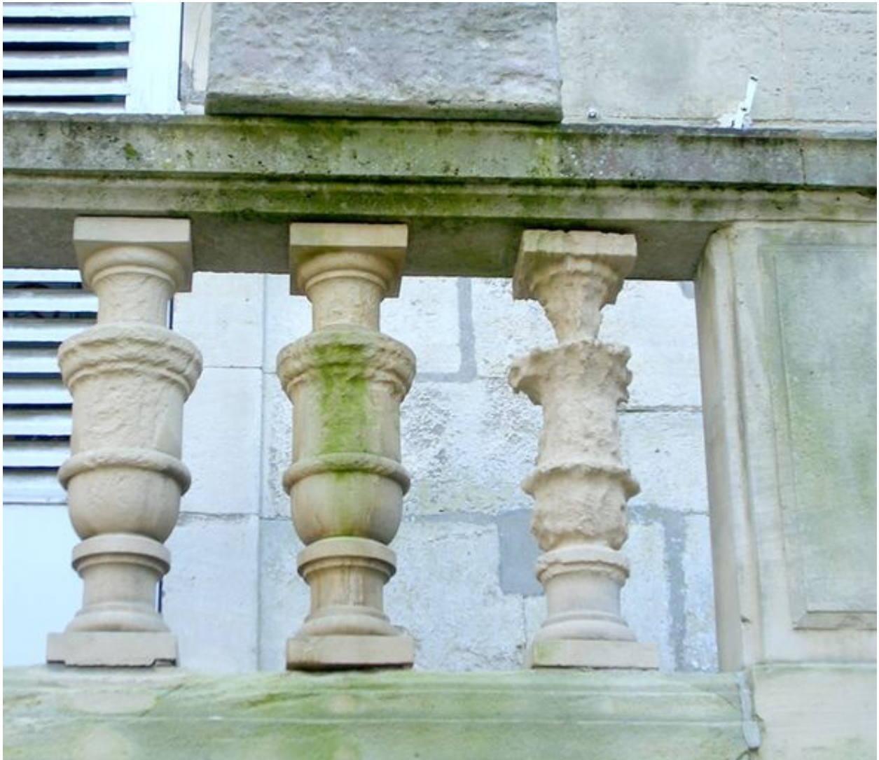
Détail des balustres en pierre de l'escalier.
