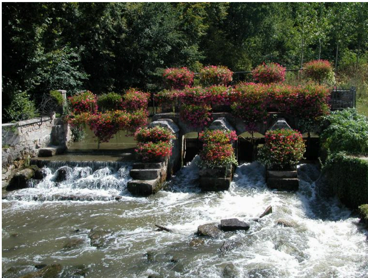
Vue du vannage de décharge et du déversoir.
