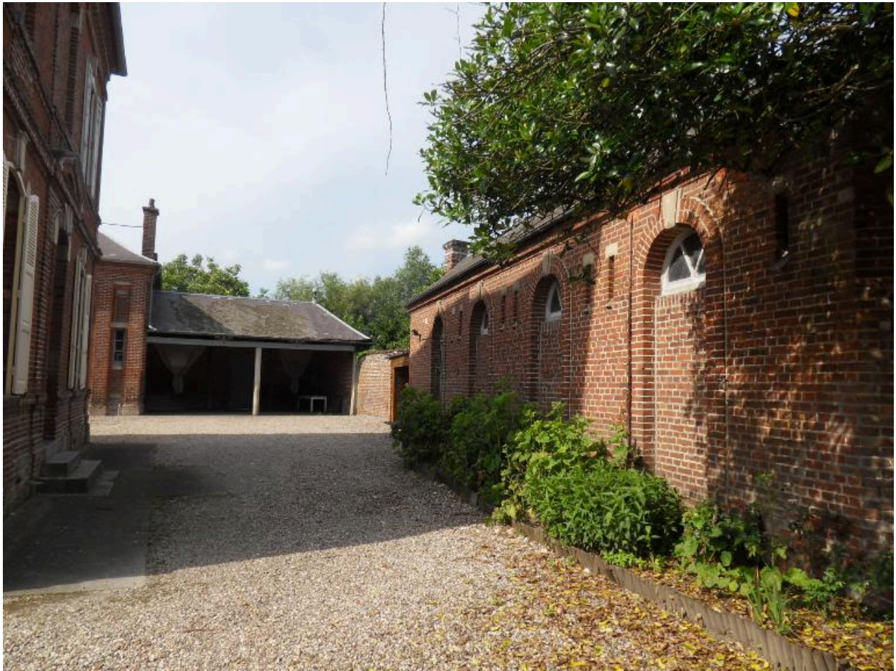
La remise de la pompe à incendie et le préau à l'arrière-plan.
