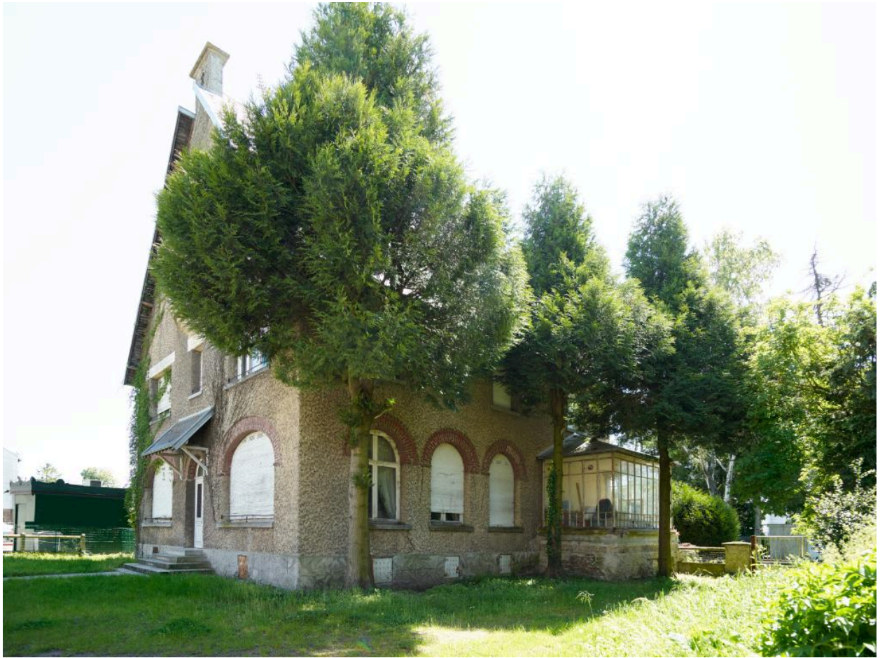
Façade latérale droite.
