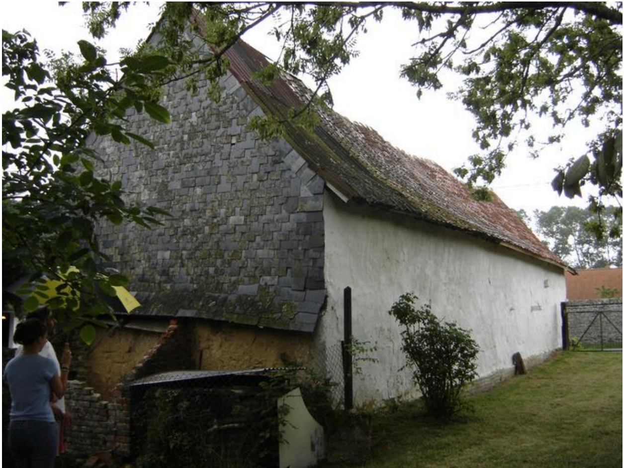
Vue postérieure du bâtiment.
